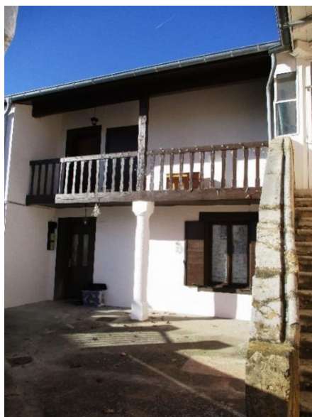
Fig 2. Maison de Jean-François Joly, second maire d'Oullins en septembre 1791. Maison typique vigneronne. En bas de l'escalier est gravée une date : 1783.
